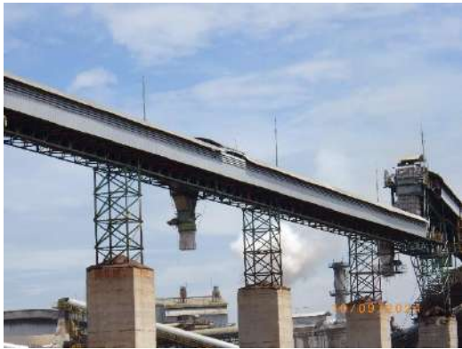
รูปที่ 2-15 การปิดครอบสายพานลำเลียงขนอ้อย
